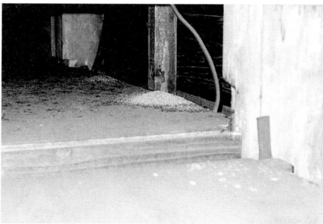
写真7 木造建築物の天井裏に堆積していたアメリカカンザイシロアリの糞
