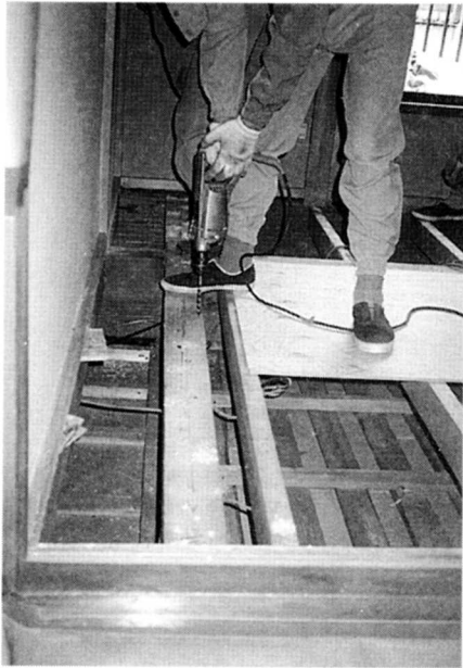
写真19 木造建物2階和室の床板を上げて構造材に穿孔しているところ
