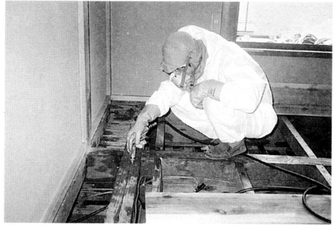
写真21 木材に勃孔された穴に薬液を注入しているところ
